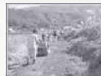
砂利舗装を アスファルト舗装へ
