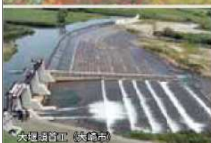
大堰通首工 (大崎市)
