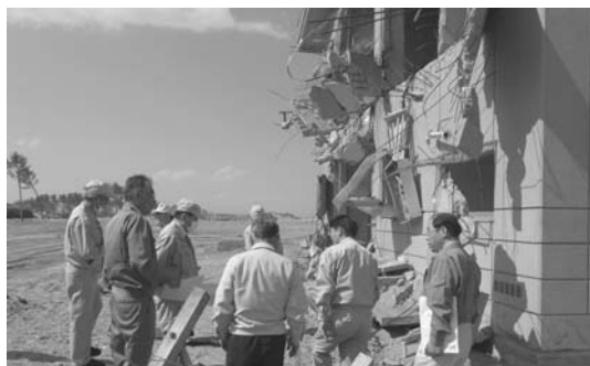
花笠第2排水機場を視察
