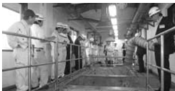
工事の進捗状況について説明
