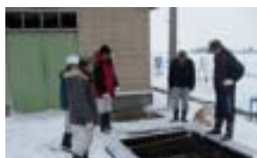
給水口の点検
