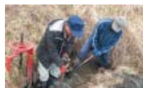
排水路の泥上げ
