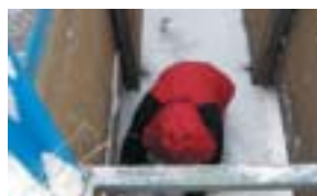
破損施設点検・補修
