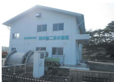
銭神第二排水機場
