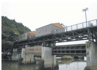
高城川防潮樋門
