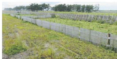
除草作業終了後の風景
