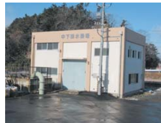
中下排水機場（復旧後）
