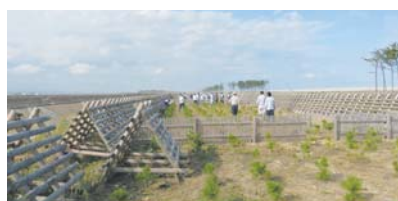
除草作業終了後の風景
