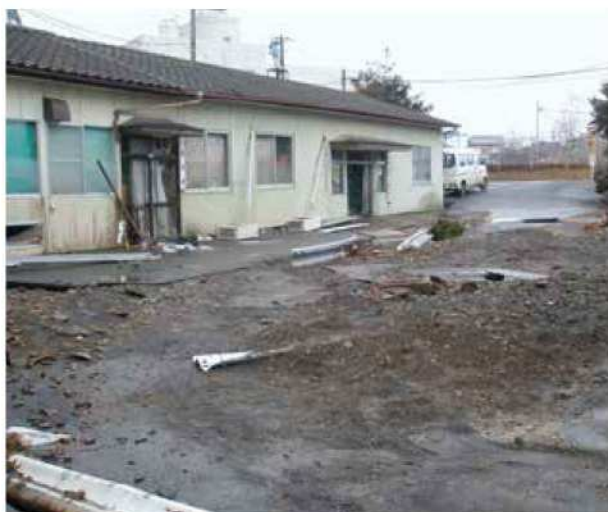
【被災した土地改良区事務所】 H23.3.12 撮影
