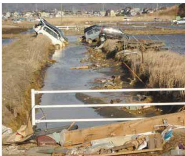
【東日本大震災の被災状況】
