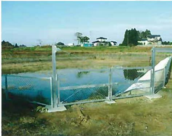
【復旧工事完了のため池】
