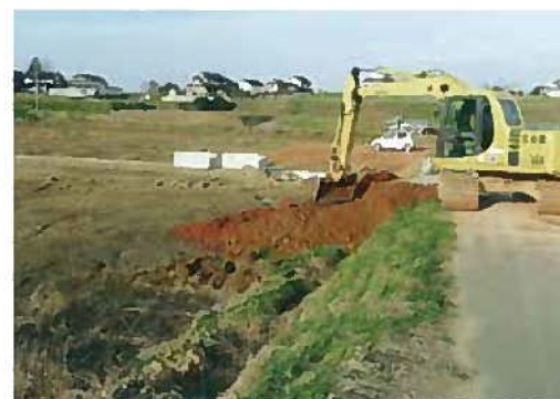
【復旧工事中の被災農地】
