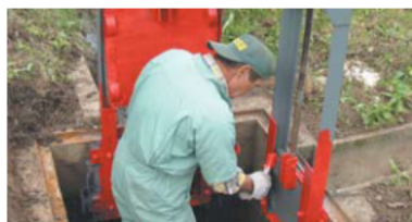
ゲートの塗装
