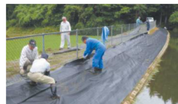
ため池堤体に防草シート張り
