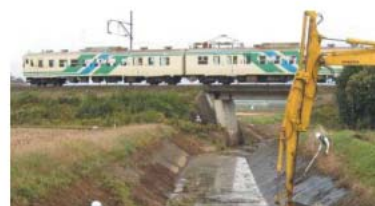
水路の泥上げ
